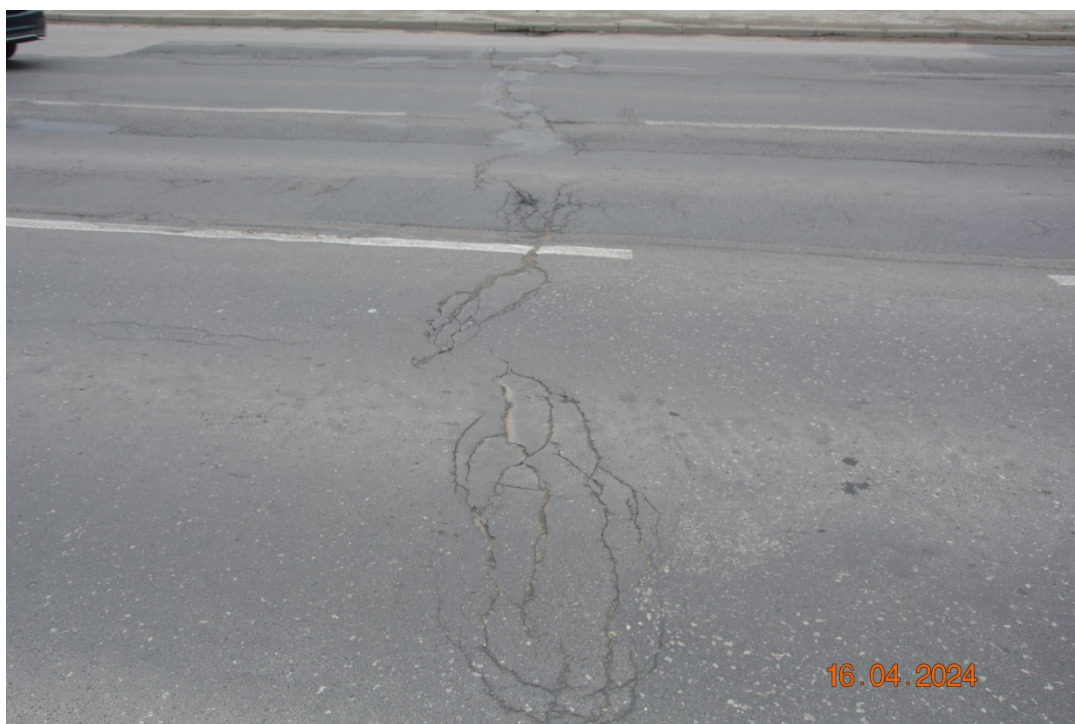
Fot. 10. Obszar dylatacyjny nad P2
