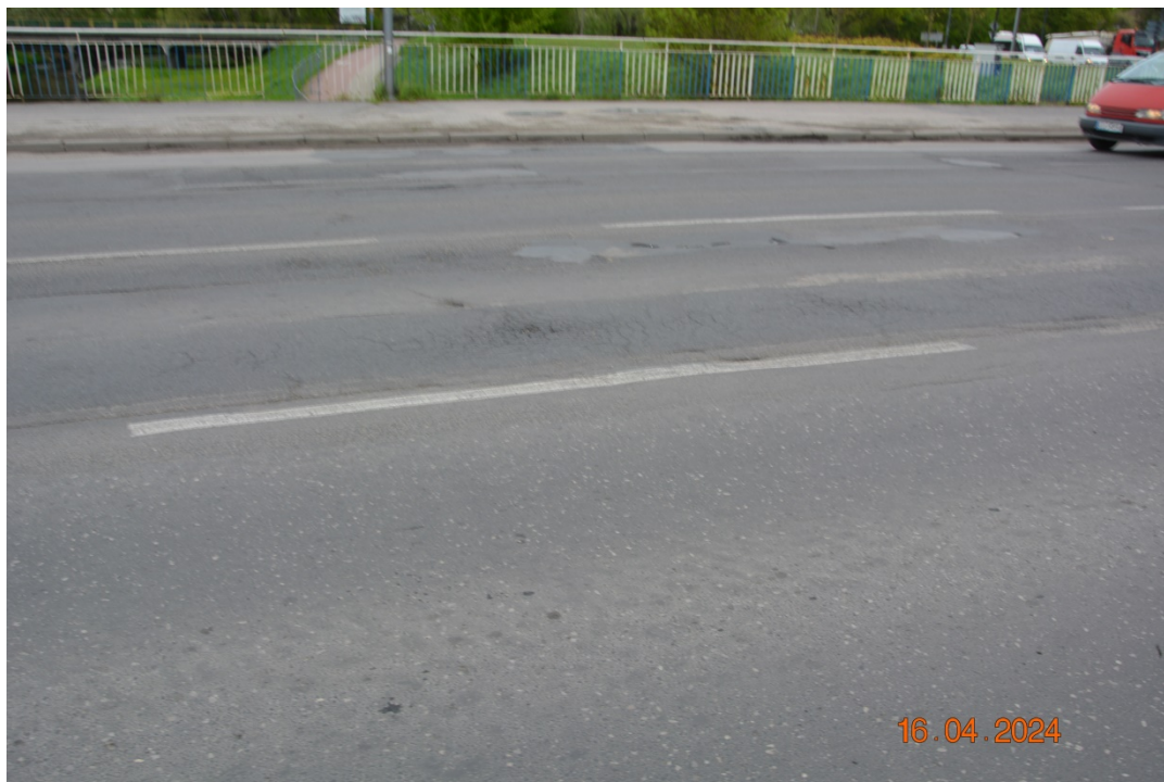
Fot. 11. Obszar dylatacyjny nad P3
