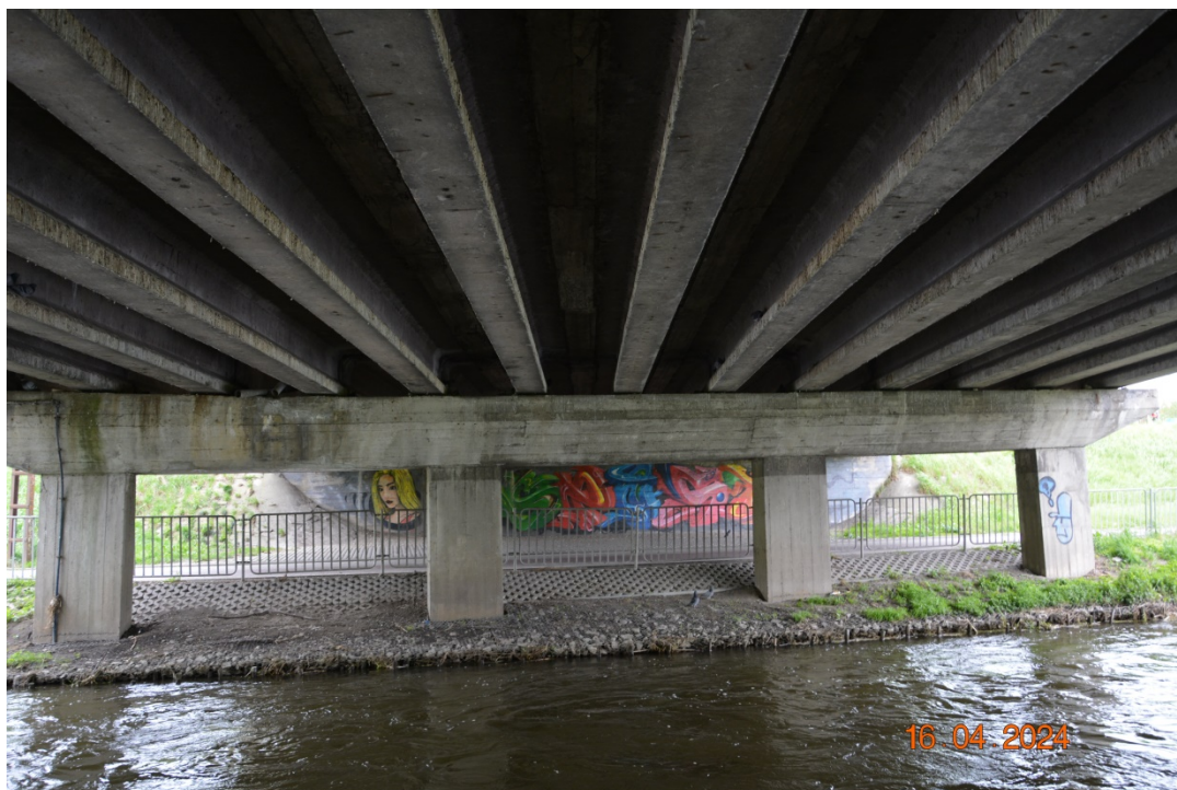
Fot. 8. Widok na podporę pośrednią P3
