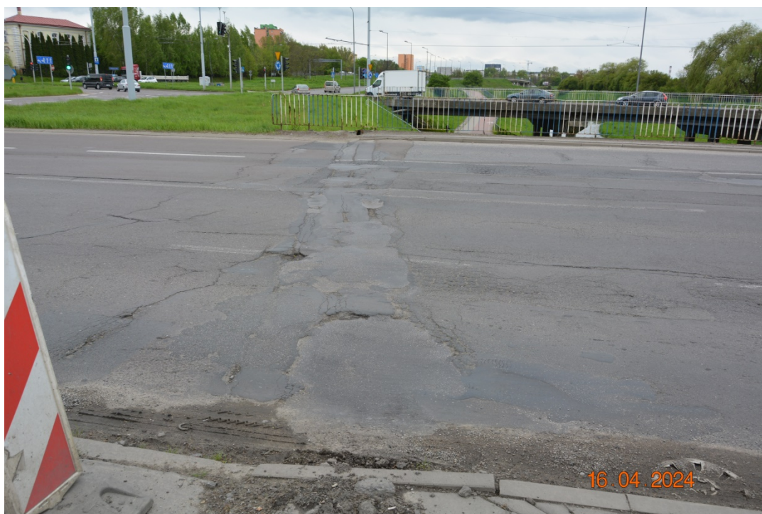
Fot. 12. Obszar dylatacyjny nad P4
