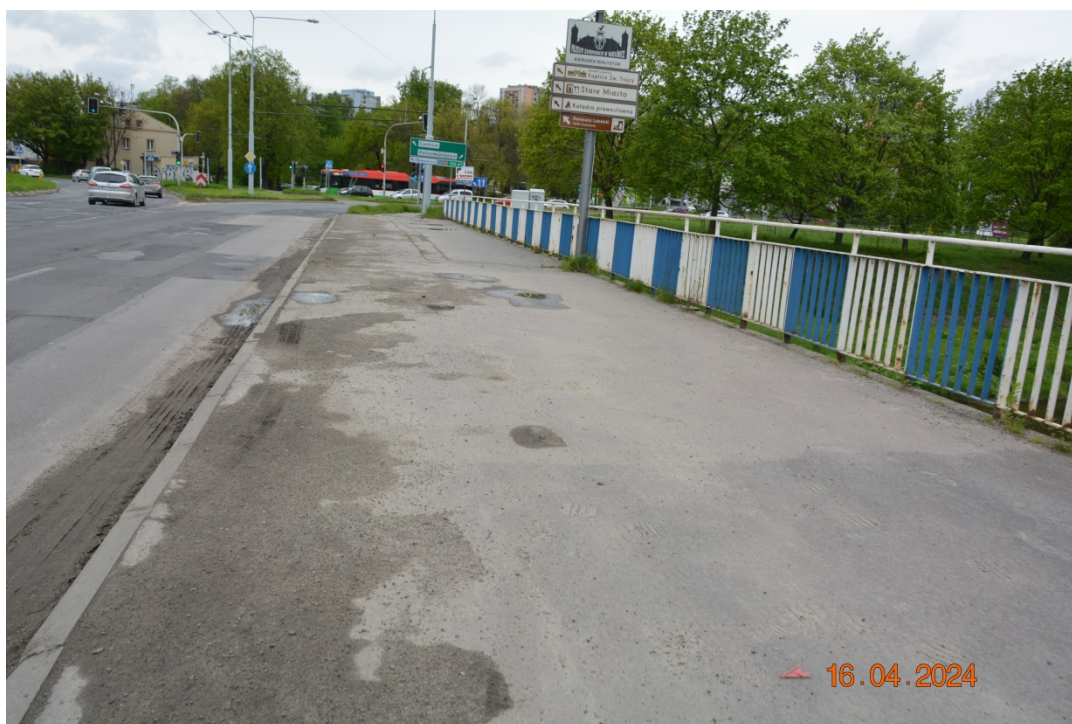
Fot. 4. Widok na chodnik od ul. Turystycznej
