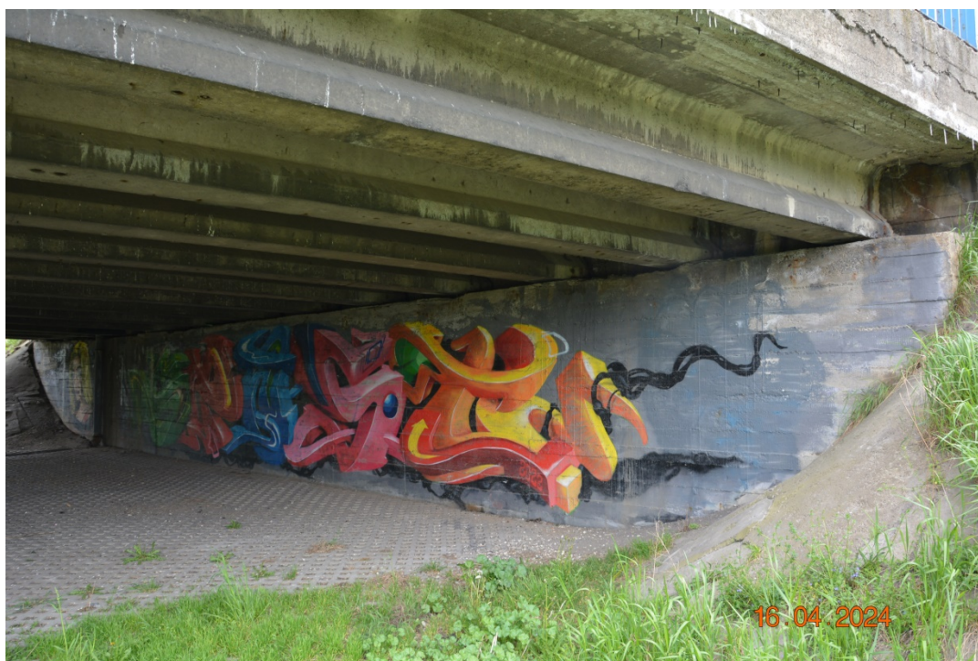
Fot. 6. Widok na podporę skrajną P4
