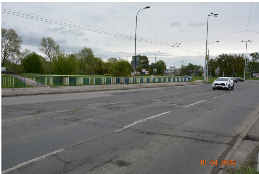
Fot. 3. Widok jezdni od ul. Andersa
