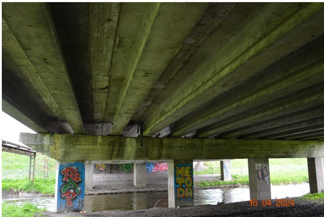
Fot. 7. Widok na podporę pośrednią P2
