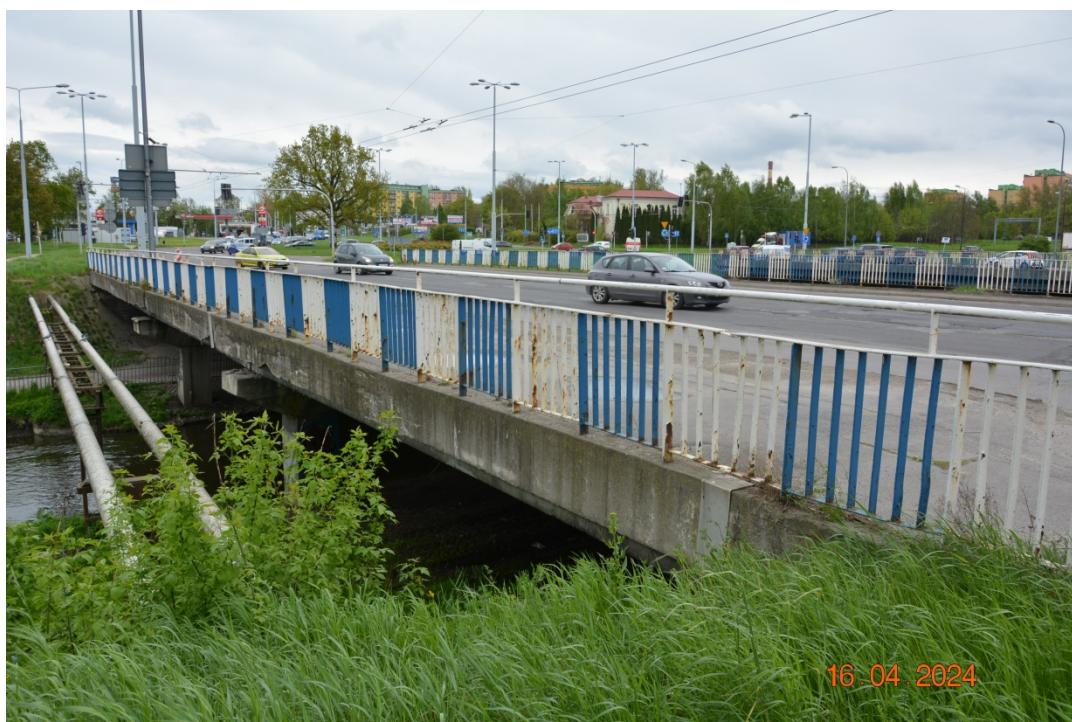
Fot. 2. Widok od strony DW
