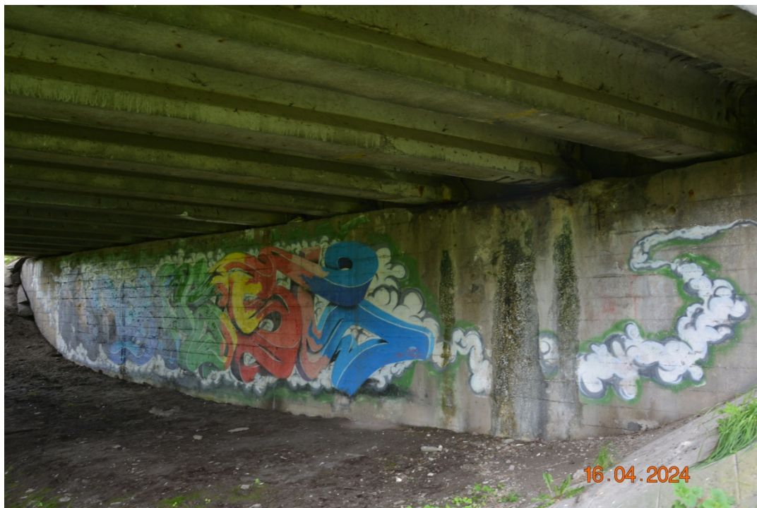
Fot. 5. Widok na podporę skrajną P1
