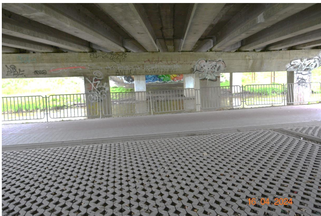
Fot. 18. Ustrój od spodu i przestrzeń podmostowa w kierunku P3
