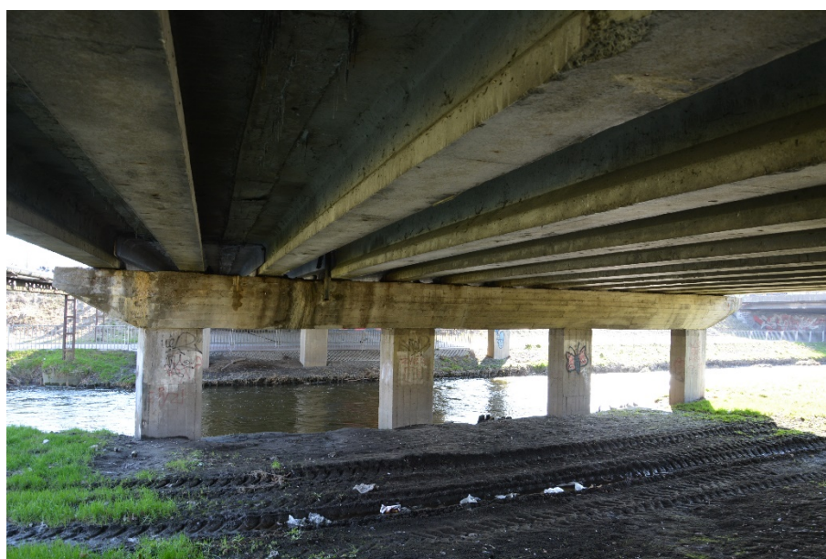
Fot. 4. Widok na ustrój i przestrzeń podmostową
