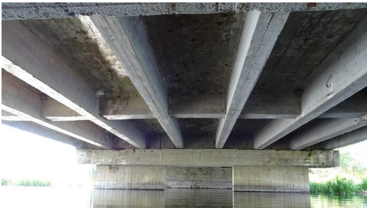
Fot. 6. Widok ogólny spodu konstrukcji przęsła i podpory nr 3
