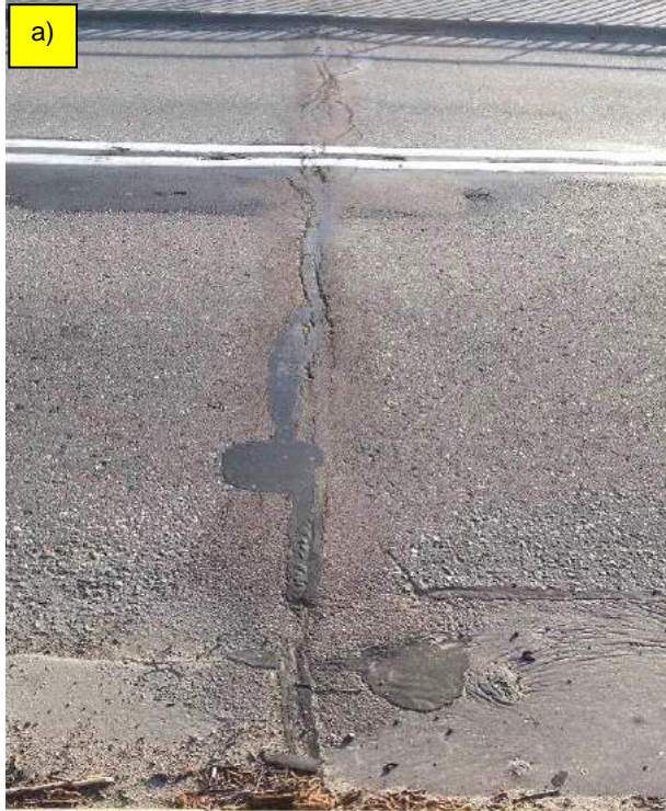
Fot. 15. Spękania i liczne naprawy nawierzchni w obrębie dylatacji nad podporą nr 2 (fot. a) i podporą nr 3 (fot. b).
