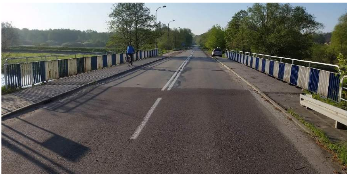
Fot. 1. Widok mostu z dojazdu od str. ul. Krężnickej
