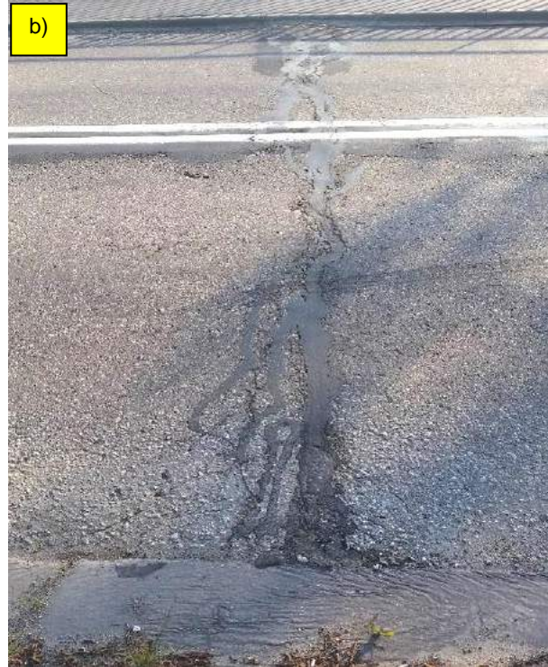
Fot. 15. Spękania i liczne naprawy nawierzchni w obrębie dylatacji nad podporą nr 2 (fot. a) i podporą nr 3 (fot. b).
