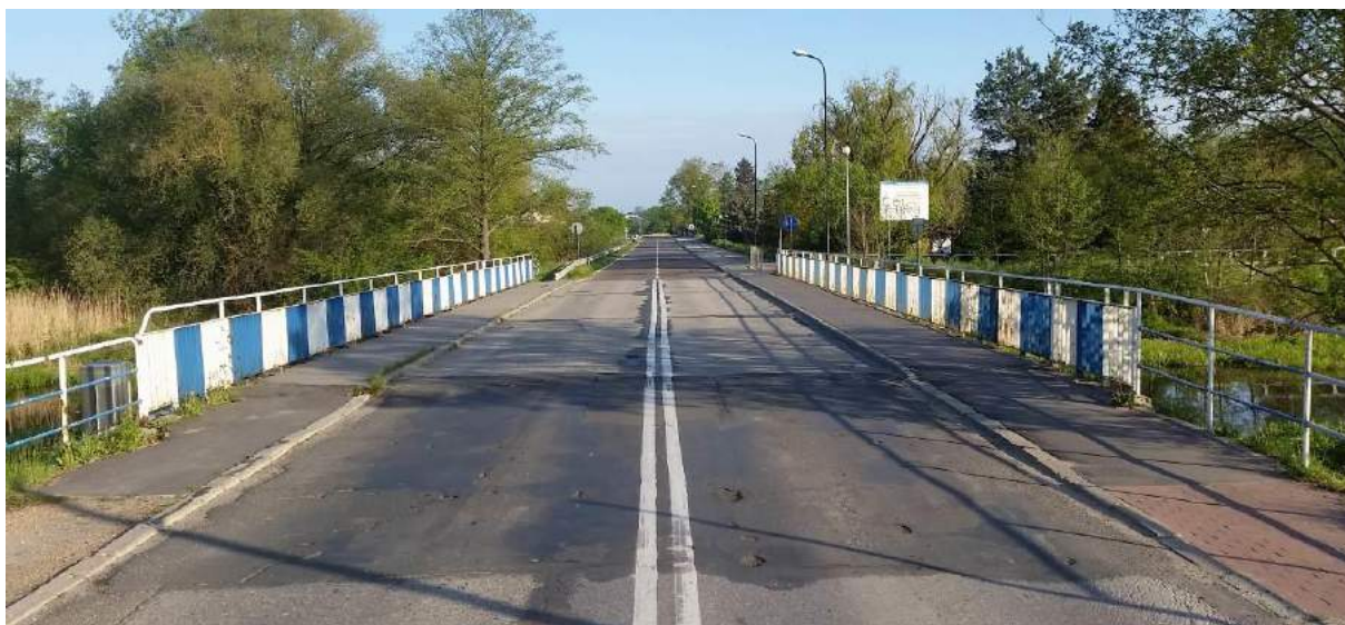
Fot. 2. Widok mostu z dojazdu od str. ul. Osmolickiej
