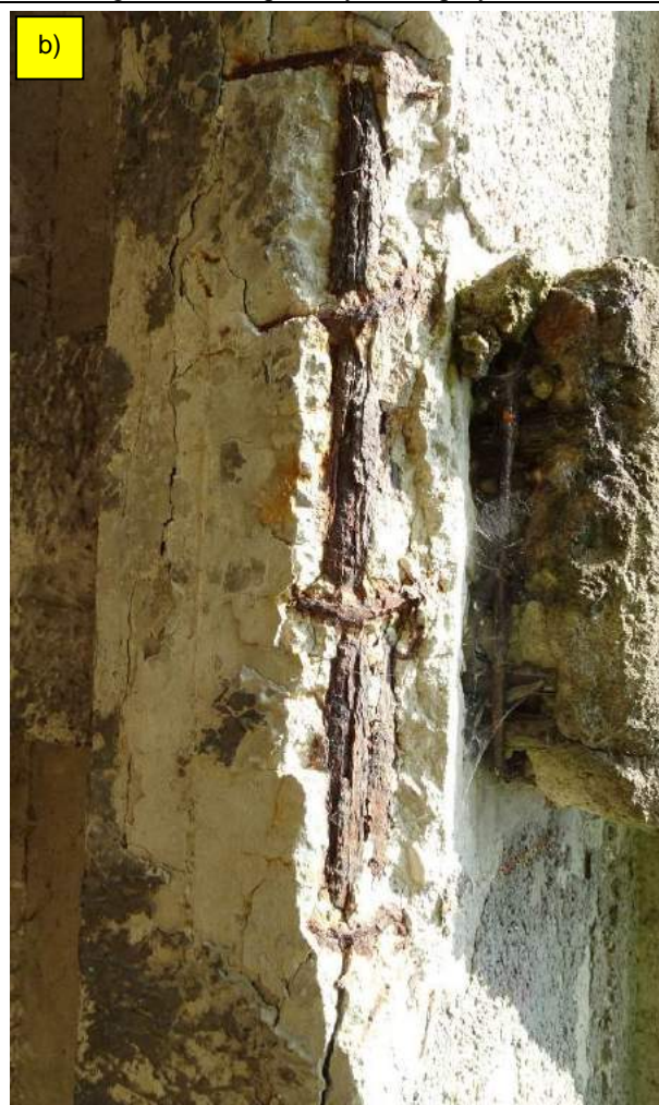
Fot. 18. Przęsło 1-2. Środek rozpiętości dźwigara skrajnego od GW (fot. a) i dźwigara skrajnego od DW (fot. b). Intensywna korozja i ubytki przekroju zbrojenia głównego i strzemion oraz spękania i ubytki otuliny betonowej.
