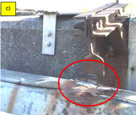
Fot. 16. Przedawaryjny stan urządzeń obcych i ich zamocowań do konstrukcji. Rozległe ubytki poszycia w rurze osłonowej (fot. a, b) oraz zerwane w wyniku korozji podwieszenia rurociągów. Uszkodzenia typowe, występują na całej długości obiektu.
