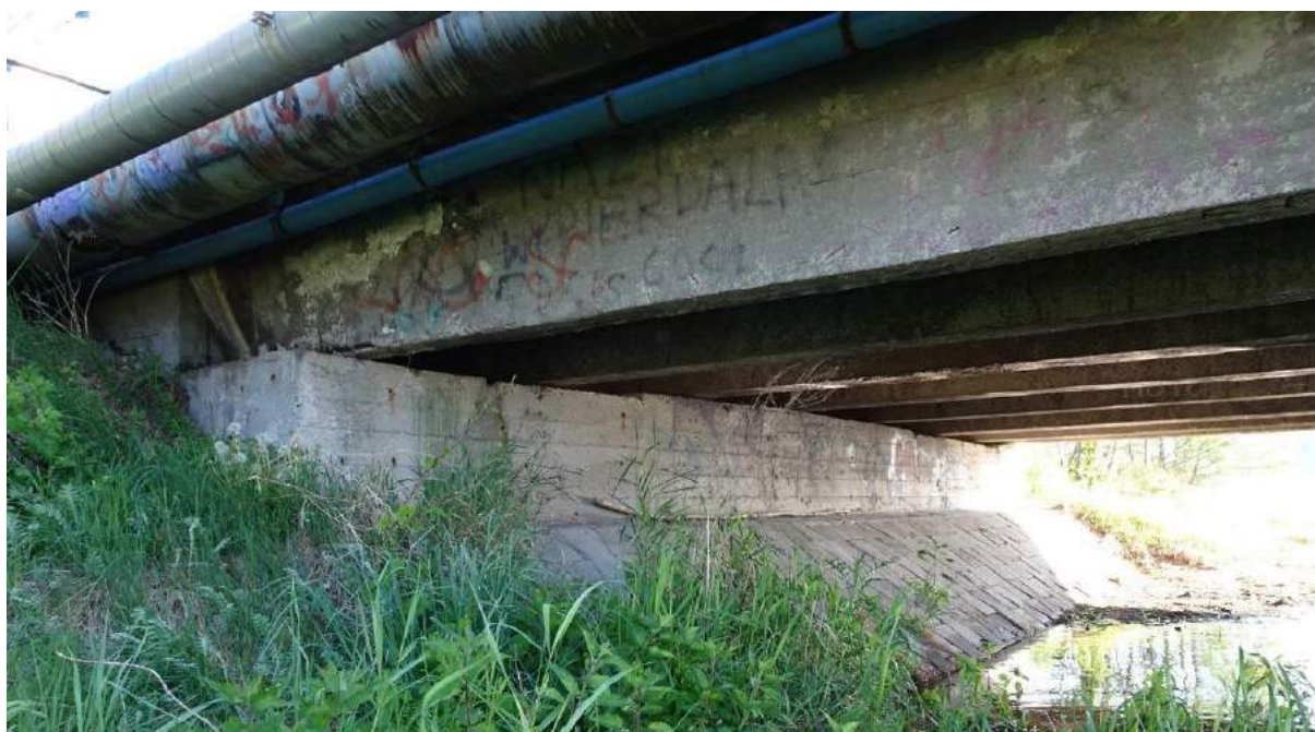
Fot. 5. Widok ogólny podpory nr 1
