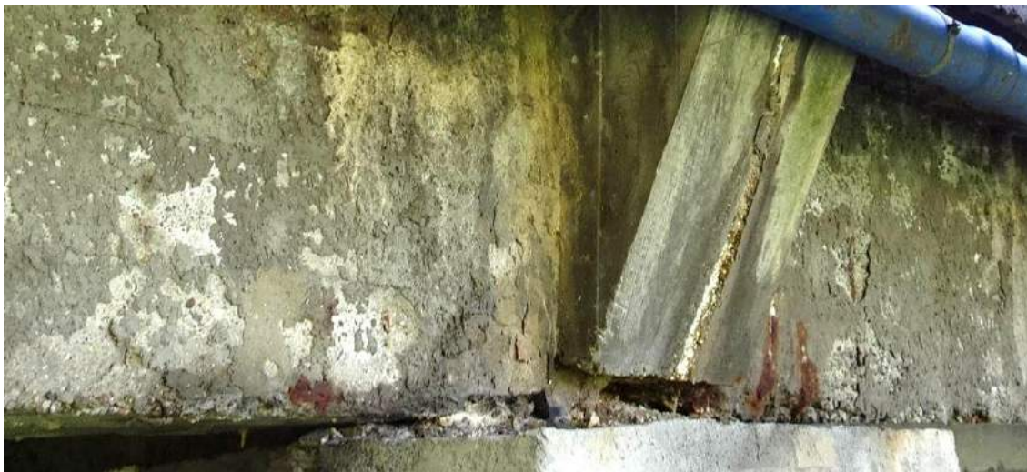
Fot. 19. Korozja strzemion w dźwigarze skrajnym od GW nad podporą nr 2. Uszkodzone (zmiażdżone) łożyska gumowe.
