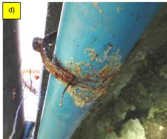
Fot. 16. Przedawaryjny stan urządzeń obcych i ich zamocowań do konstrukcji. Rozległe ubytki poszycia w rurze osłonowej (fot. a, b) oraz zerwane w wyniku korozji podwieszenia rurociągów. Uszkodzenia typowe, występują na całej długości obiektu.
