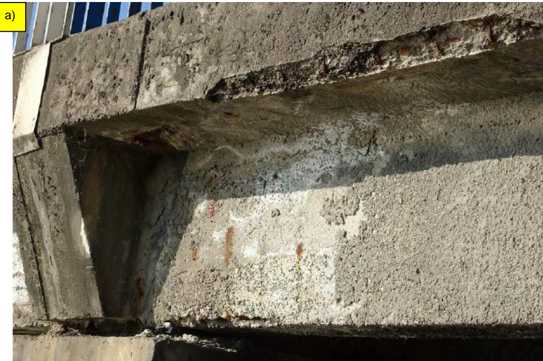
Fot. 19. Korozja strzemion w dźwigarze skrajnym od GW nad podporą nr 2. Uszkodzone (zmiażdżone) łożyska gumowe.
