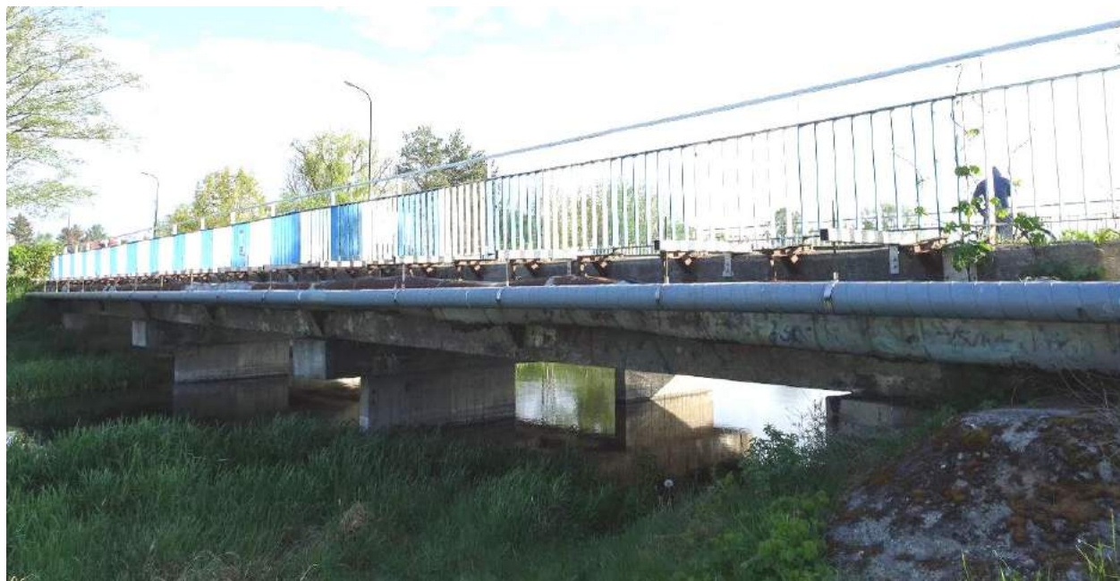
Fot. 3. Widok ogólny mostu od strony górnej wody (GW)
