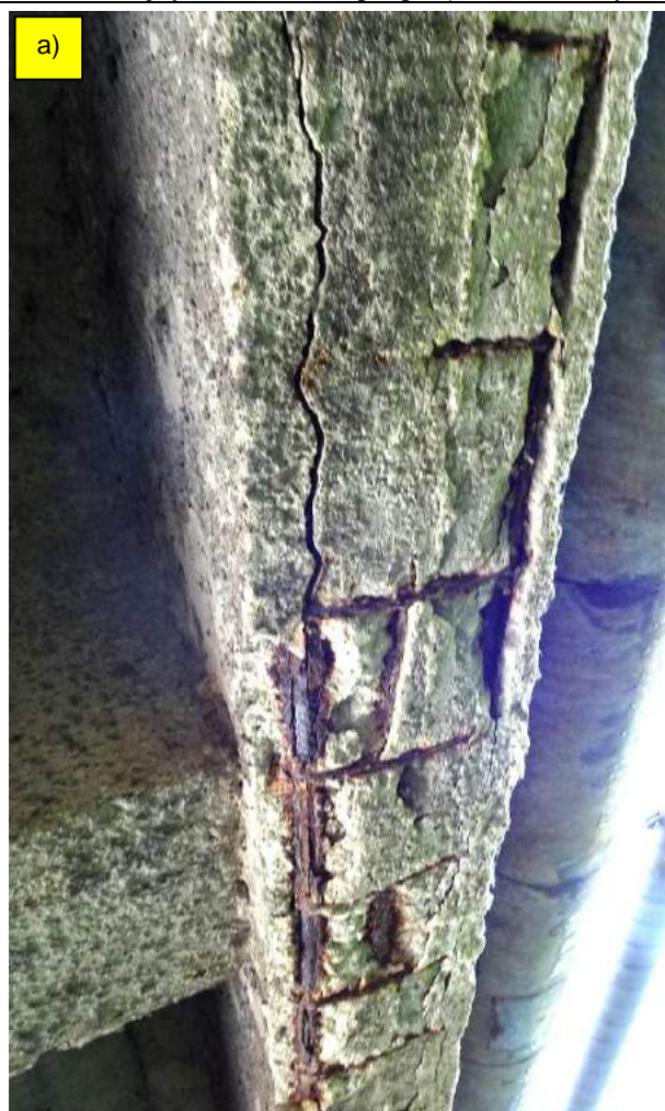
Fot. 18. Przęsło 1-2. Środek rozpiętości dźwigara skrajnego od GW (fot. a) i dźwigara skrajnego od DW (fot. b). Intensywna korozja i ubytki przekroju zbrojenia głównego i strzemion oraz spękania i ubytki otuliny betonowej.
