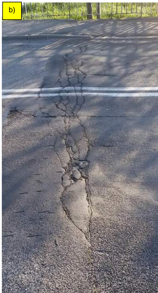
Fot. 14. Spękania nawierzchni jezdni w obrębie dylatacji nad podporą nr 1 (fot. a) oraz zniszczenie struktury nawierzchni w obrębie dylatacji nad podporą nr 4 (fot. b).
