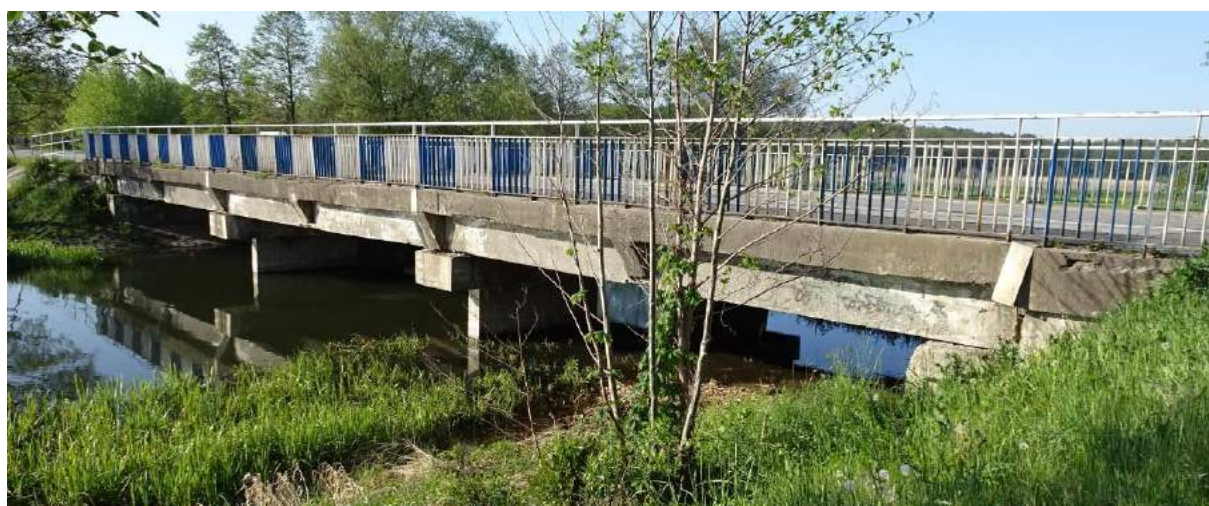
Fot. 4. Widok ogólny mostu od strony dolnej wody (DW)
