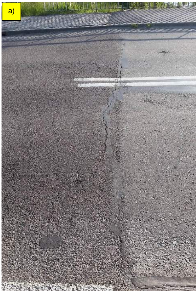
Fot. 14. Spękania nawierzchni jezdni w obrębie dylatacji nad podporą nr 1 (fot. a) oraz zniszczenie struktury nawierzchni w obrębie dylatacji nad podporą nr 4 (fot. b).
