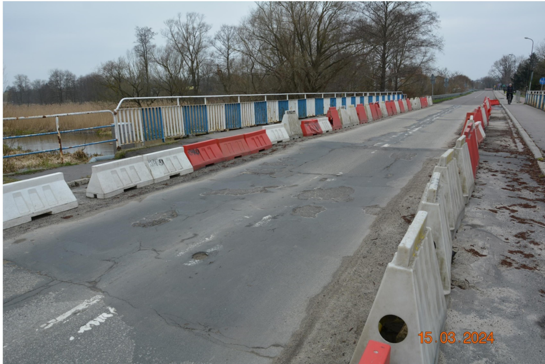
Fot. 3 Widok na jezdnię mostu
