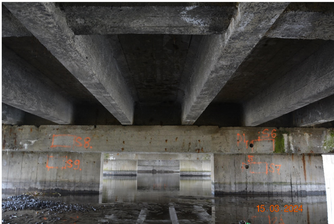
Fot. 4 Przestrzeń podmostowa
