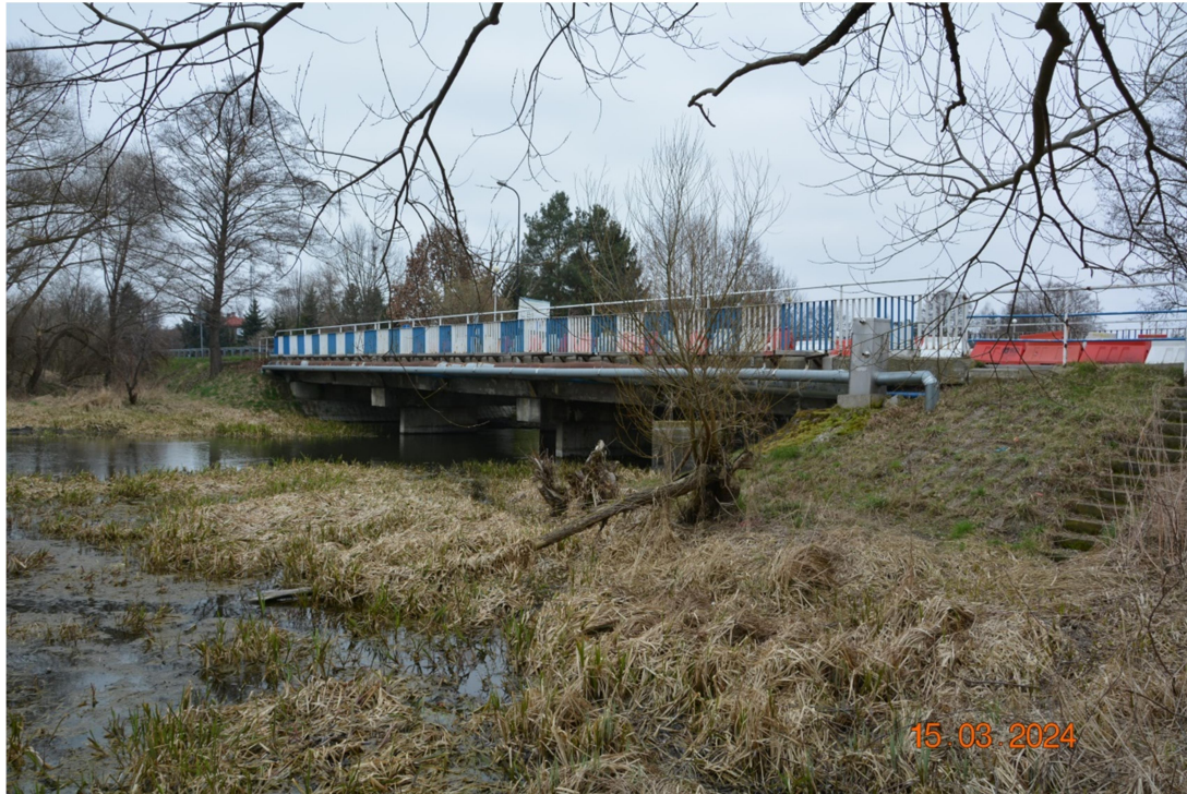
Fot. 1 Widok mostu od strony górnej wody
