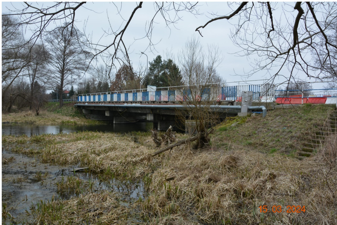
Fot. 2 Widok mostu od strony dolnej wody
