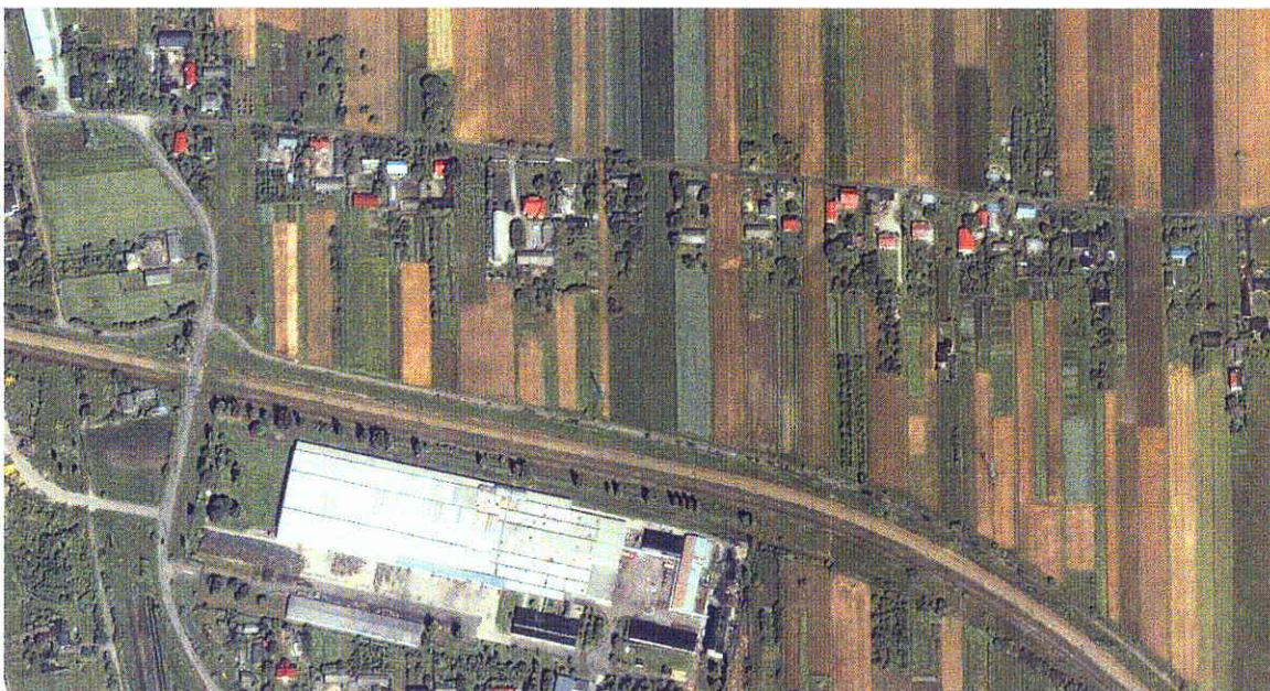
Fot. 7 Przebieg linii kolejowej na odcinku ul. Turystyczne - Chełm przy zabudowie zagrodowej 1-2-kondygnacyjnej przy ul. Dziubińskiej
