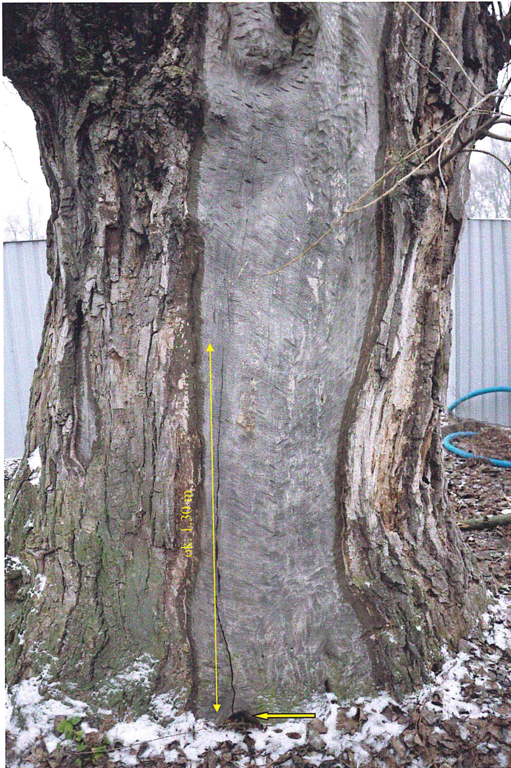
Fot. 4. Okorowana część pnia. U podstawy niewielki ubytek wgłębny i biegnące ku górze pęknięcie (fot. M. Dąbski)
