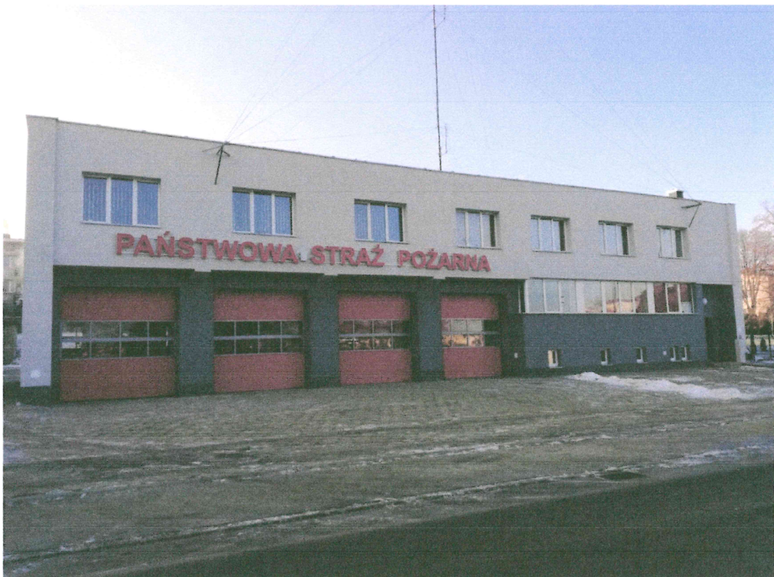
Budynek JRG w Bychawie
