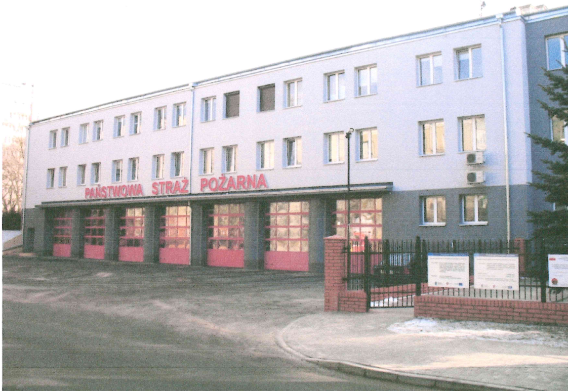
Budynek główny Komendy Miejskiej PSP w Lublinie
