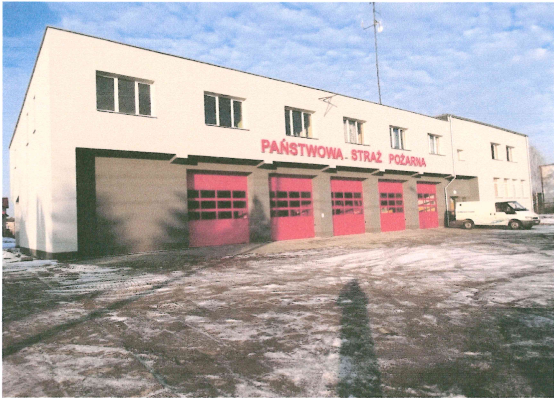
Budynek JRG w Bełżyczach
