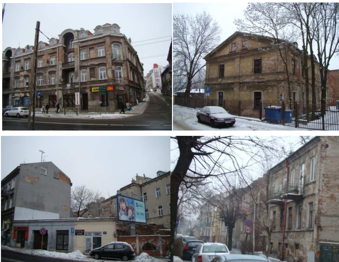
Zdjęcie 2.2 - przykłady zabudowy mieszkaniowej w Śródmieściu Lublina (zdjęcia wykonane na zlecenie UM Lublin).
