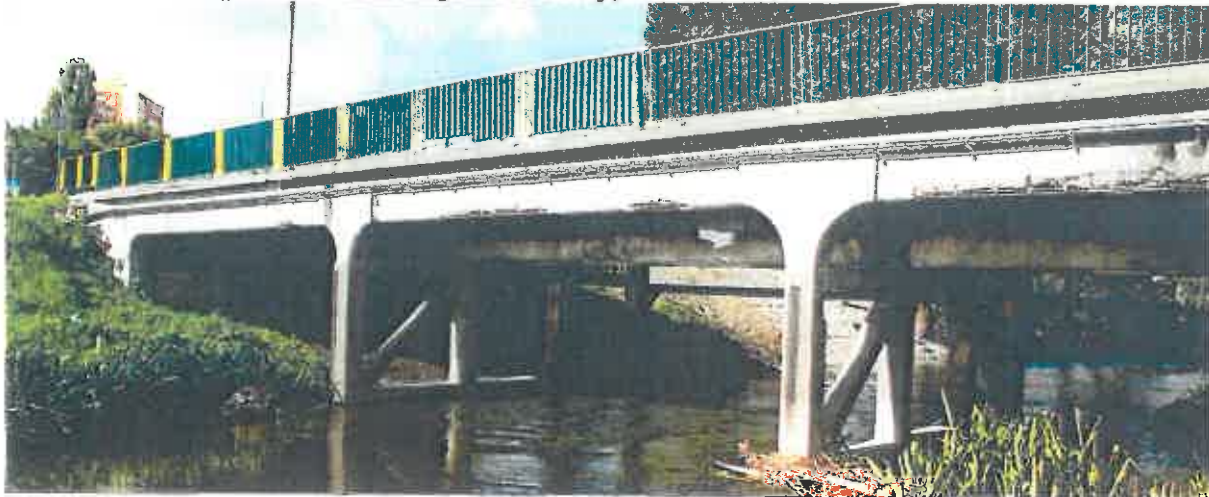
Rys. 70. Widok mostu na Kalinowszczyźnie od napływu; stan - 2013 r.
