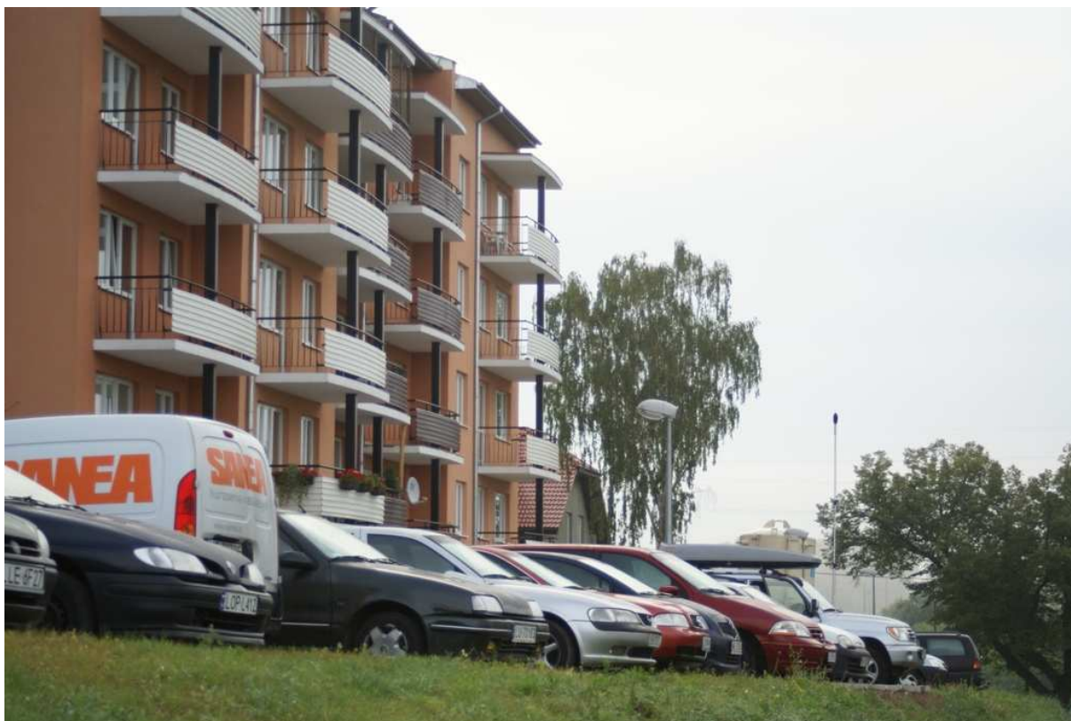
Fot. 3 Zabudowa mieszkaniowa wielorodzinna przy ul. Wąwozowej (równoległa do Wyżynnej) najbardziej eksponowana na hałas kolejowy.
