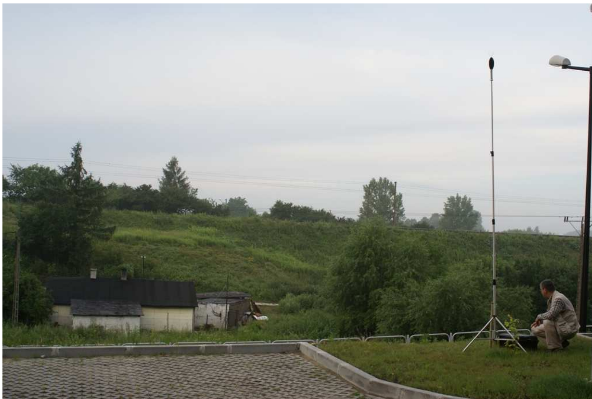
Fot. 2 Linia kolejowa w rejonie ul. Wyżynnej i ul. Diamentowej biegnie po nasypie co ułatwia propagację dźwięku na kierunku północnym w stronę zabudowy mieszkaniowej
