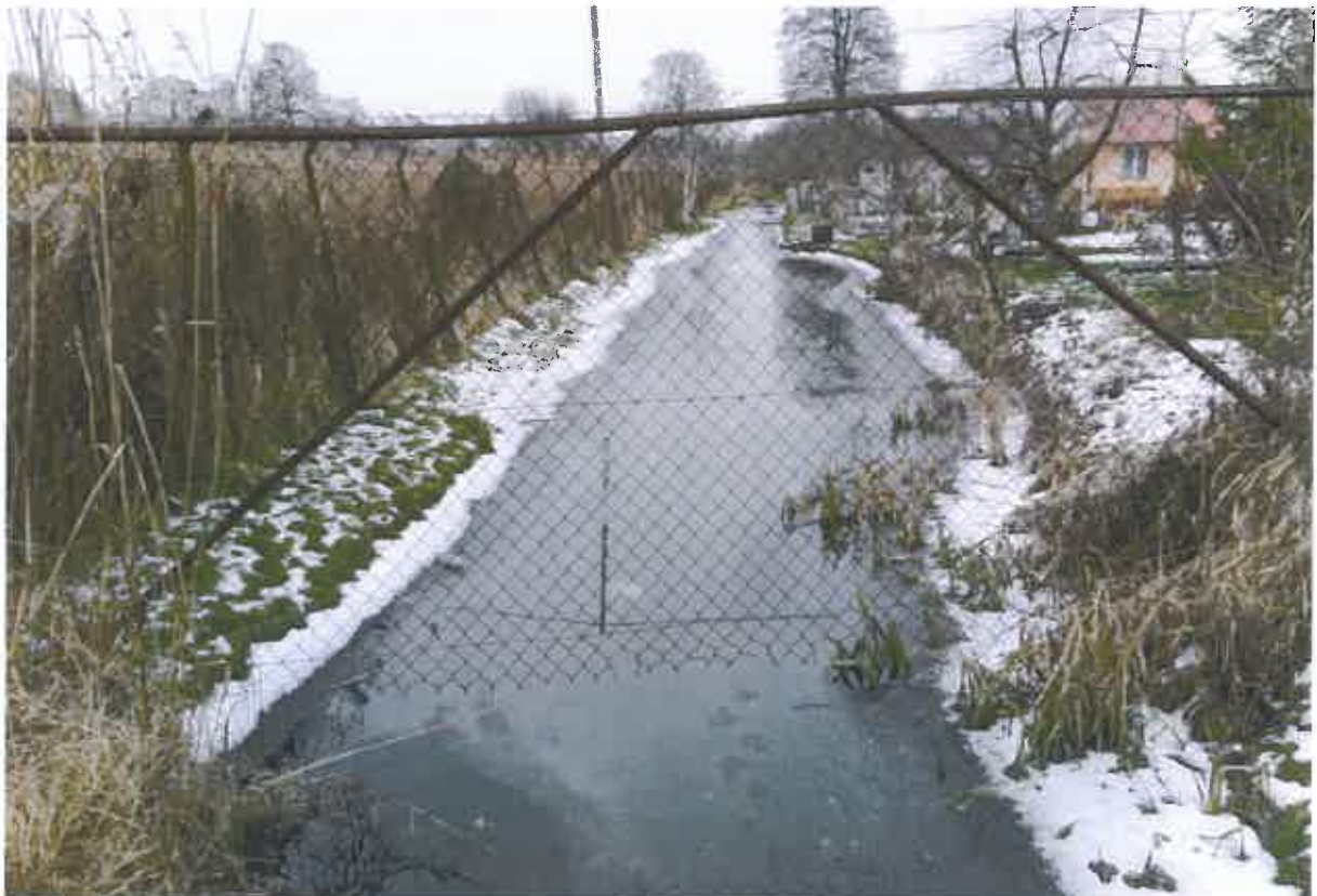
Fot. 2. Zdjęcie udroźnionej części rowu melioracyjnego na terenie ogrodu działkowego, działka nr 1, arkusz 11, obręb 20.
