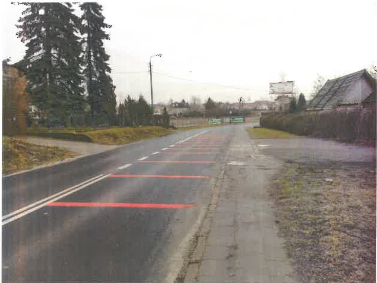
Rys. 2. Oznakowanie poziome jezdni zwiększające uwagę przed ostrym zakrętem.
