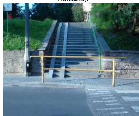
Fot. 22. Zbyt wąski chodnik dodatkowo ograniczony barierką - osiedle Niepodległości przy ul. Andersa. (zdj. TransEko).
