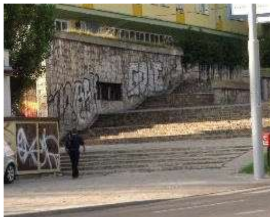
Fot. 20. Ul. Lwowska – brak pochylni przy schodach (zdj. TransEko).
