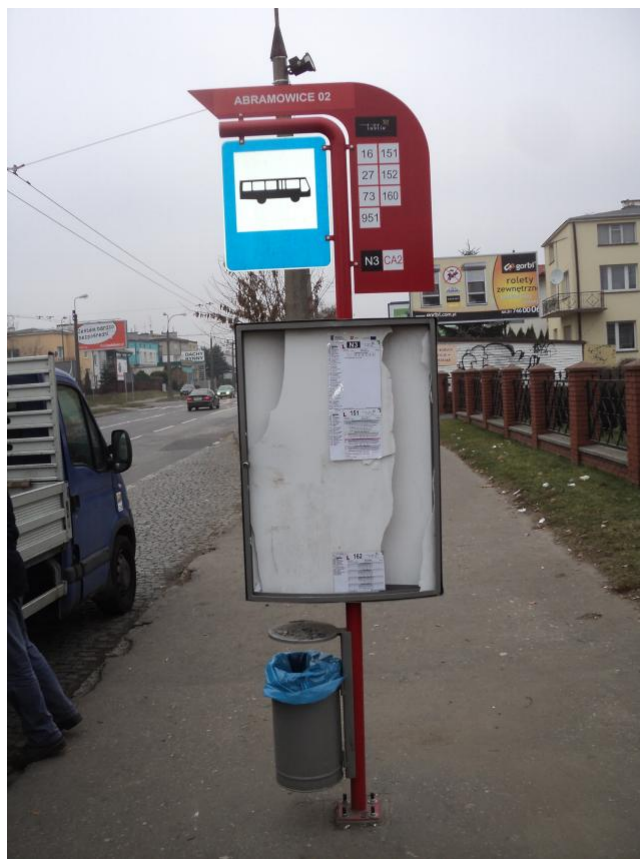
Zdjęcie nr 1: Przykład wandalizmu w komunikacji miejskiej – zniszczony najnowszy słupek przystankowy, wybita szyba gabloty przystankowej. Autor: ZTM Lublin
