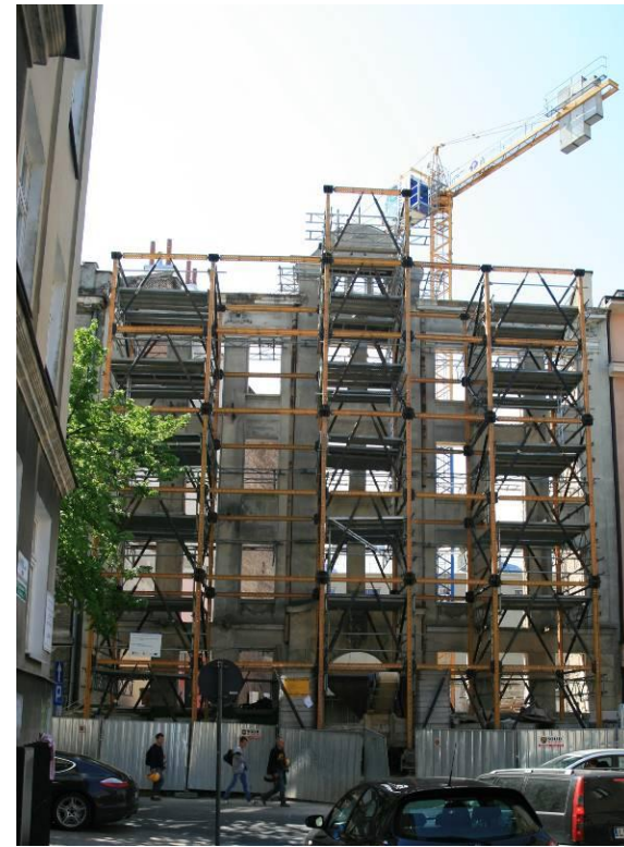
Budowa nowego obiektu na zamknięciu ul. Hipotecznej
