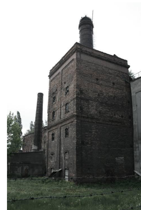
Pozostałości zabudowy przemysłowej przy ul. Misjonarskiej
