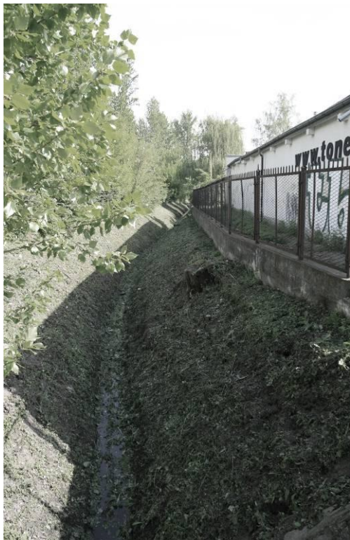
Rów melioracyjny przy ul. Rusalki
