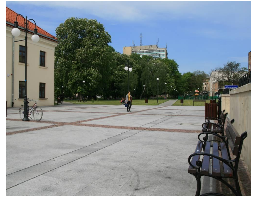
Zmodernizowana przestrzeń publiczna przed Domem Kultury przy ul. Peowiaków
