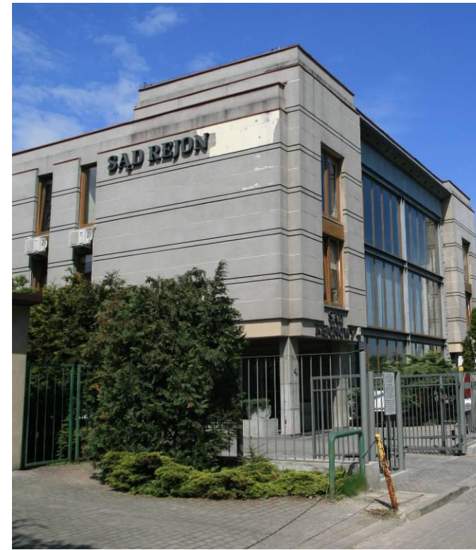
Budynek Sądu Rejonowego przy ul. Bocznej Lubomelskiej
