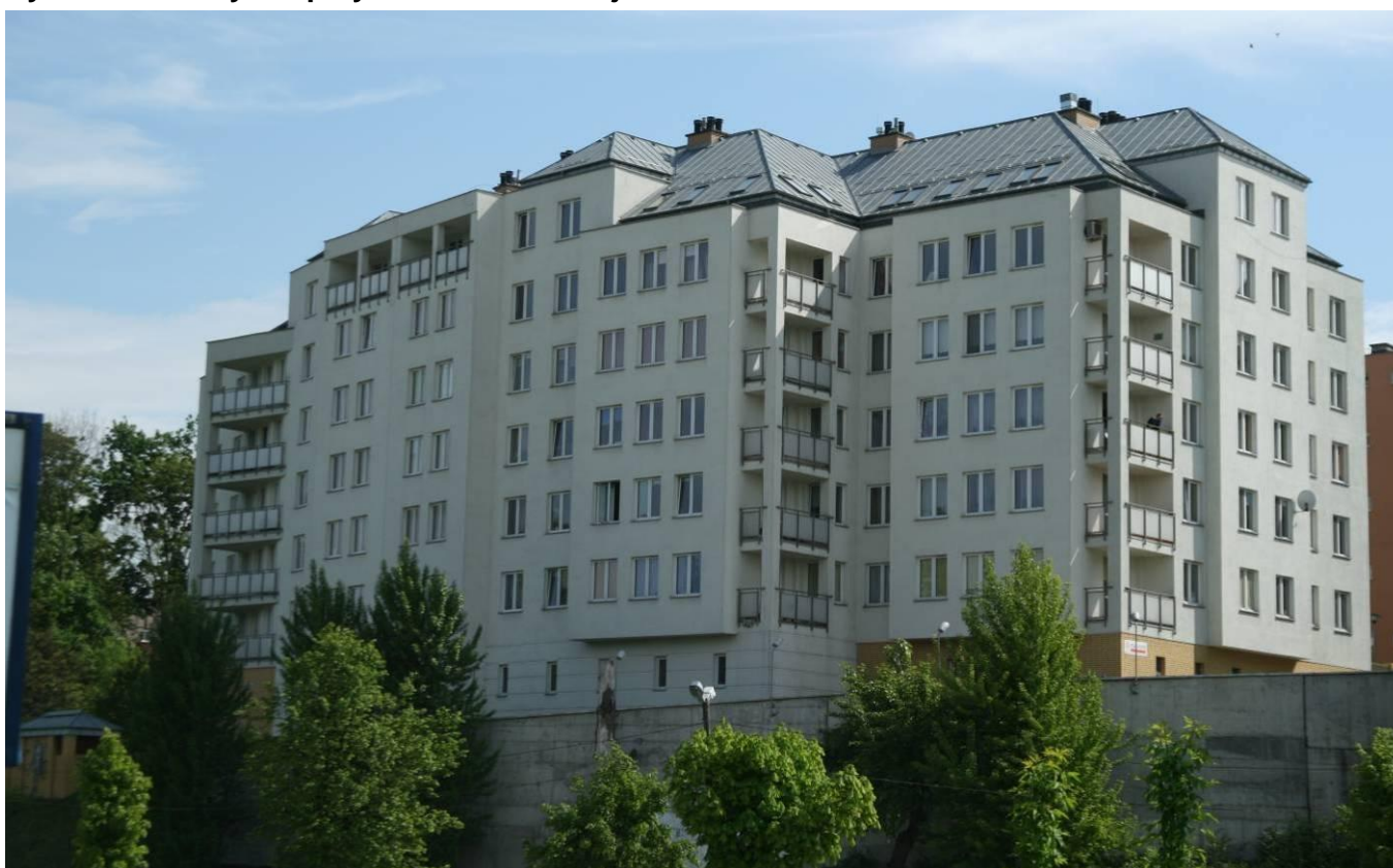
Rys. III.4.5. Budynek mieszkalny położony przy ul. Niecałej
