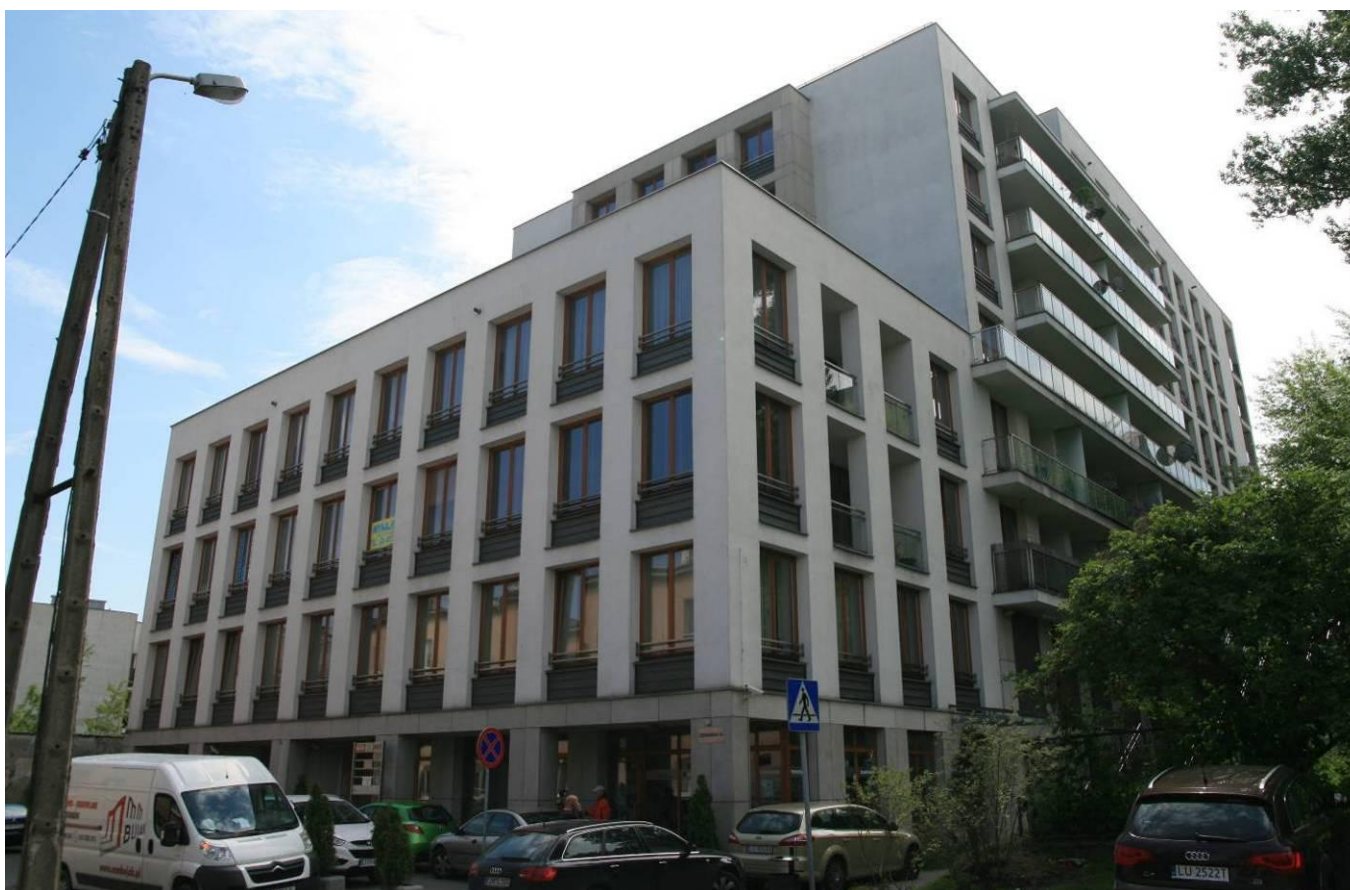
Rys. III.4.4. Budynek przy ul. Czechowskiej 8
