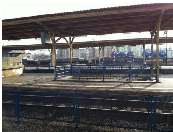
Fot. 2.6. Dworzec Lublin (Główny) – widok na perony 2 i 3
