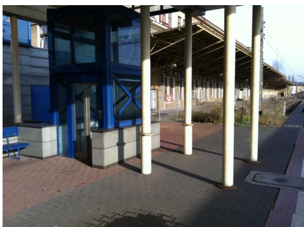
Fot. 2.7. Dworzec Lublin (Główny) – winda z peronu 1 do tunelu
