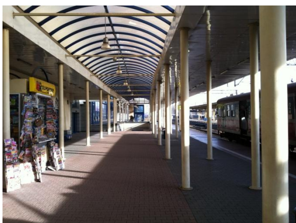
Fot. 2.5. Dworzec Lublin (Główny) – widok na zmodernizowany peron 1
