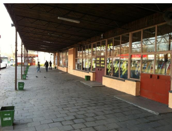
Fot. 2.17. Dworzec Południowy autobusowy – budynek dworcowy
