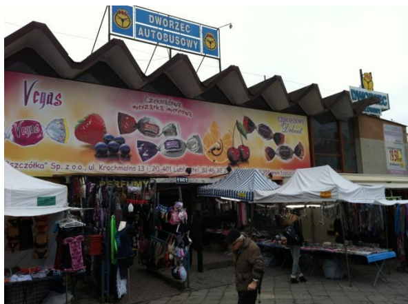
Fot. 2.13. Główne wejście do hali Dworca Głównego autobusowego zastawione straganami
