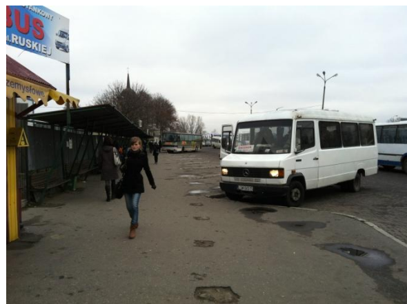
Fot. 2.16. Dworzec Główny autobusowy – widok na perony po północnej stronie dworca
