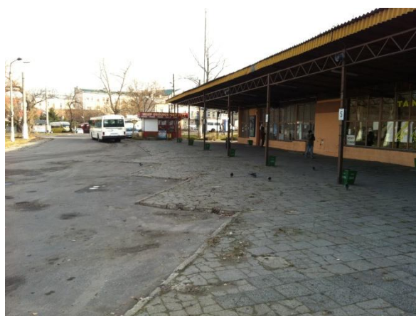
Fot. 2.18. Dworzec Południowy autobusowy – widok na perony
