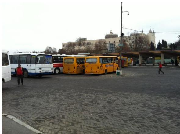
Fot. 2.15. Dworzec Główny autobusowy – widok na plac manewrowy dla autobusów i perony
