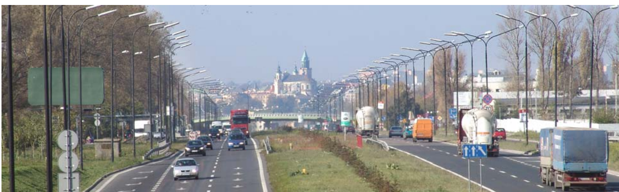
Ryc. 2.12. Widok osiowy w Aleję Wincentego Witosa z wiaduktu na ulicy Grygowej (DW-09)
