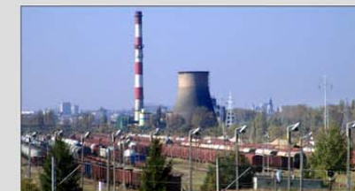
DW-08 – Widok z wiaduktu przy ulicy Grygowej
