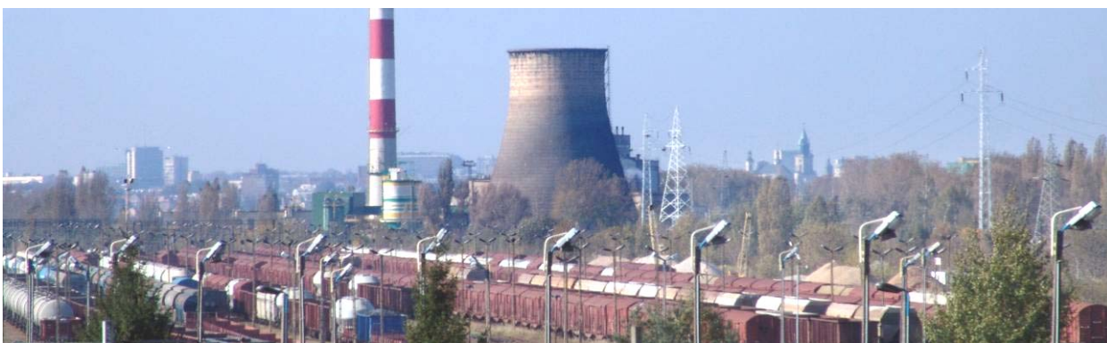
Ryc. 2.11. Widok z wiaduktu przy ulicy Grygowej (DW-08)
