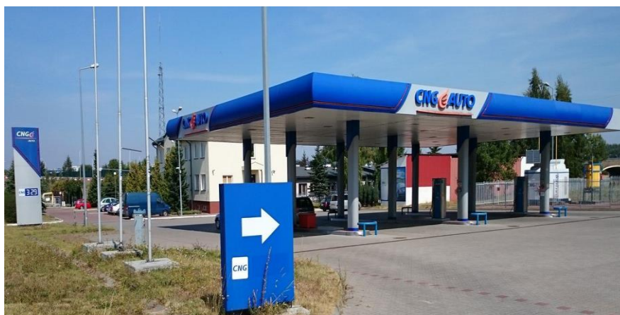
Zdjęcie 9 Stacja tankowania sprężonego gazu ziemnego
