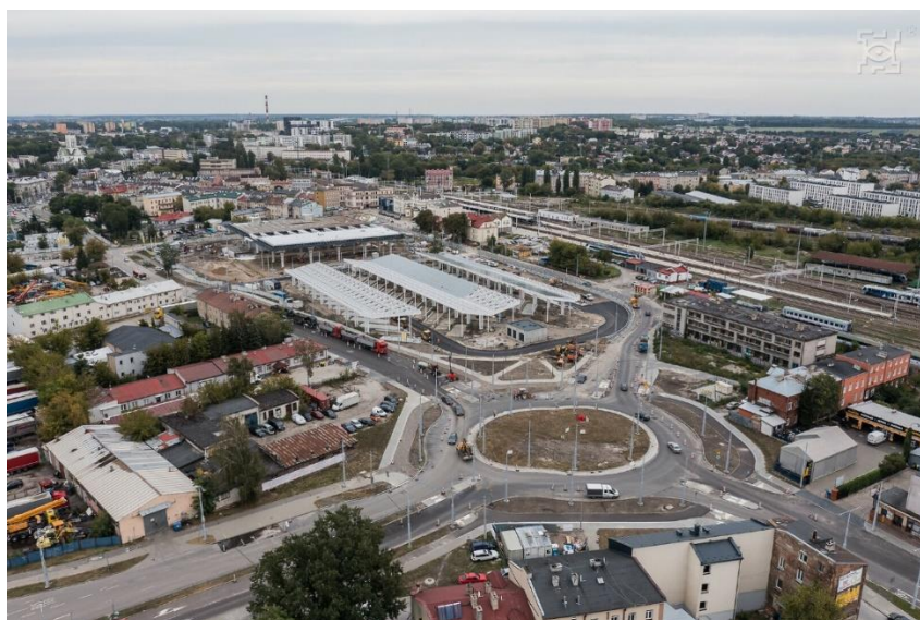
Rysunek 18. Budowa Dworca Metropolitalnego (źródło: lublin.eu)
